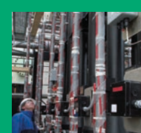
Montagen von Begleitheizungen
